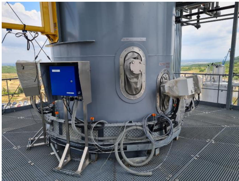
Слика 8. Један од мерних отвора на димњаку инсинератора отпада
